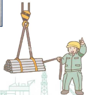
振れ止め介添えロープの結び方
