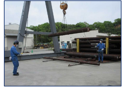
吊り高さ よし!
