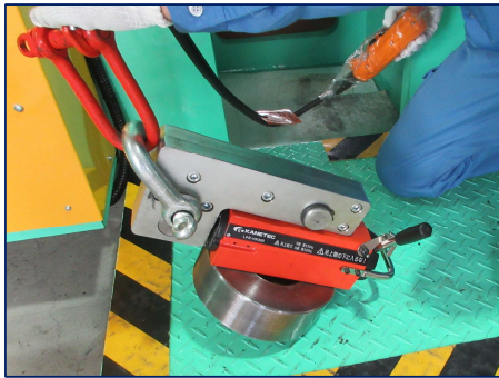
ダイス交換用ジブクレーン作業
