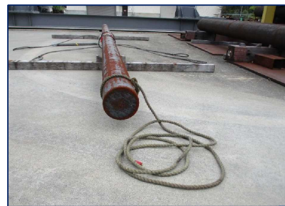
振れ止め介添えロープの結び方
